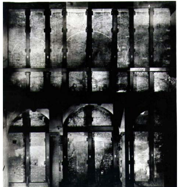
Reticolo numerico dei punti di coordinate note, sovrapposto alla restituzione schematica della parete dipinta – originale in scala 1:20 a sinistra. Raddrizzamento del retro del muro del Cenacolo a destra.
